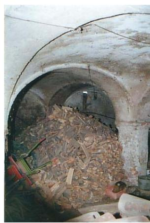
Vista delle volte a vela poggianti sulle strutture perimetrali.
