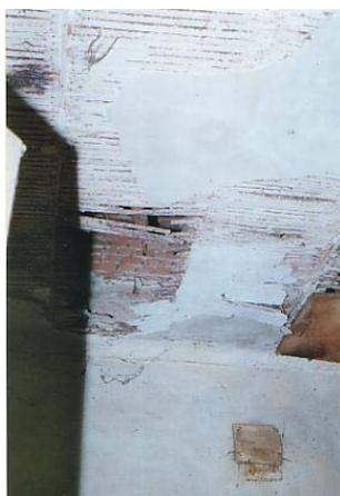
Particolare dell'antica struttura di copertura incannicciata.
