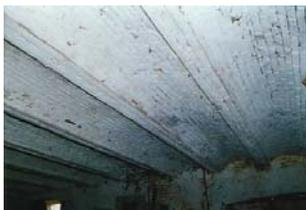
Particolare delle volte laterizie interne a copertura dell'edificio.
