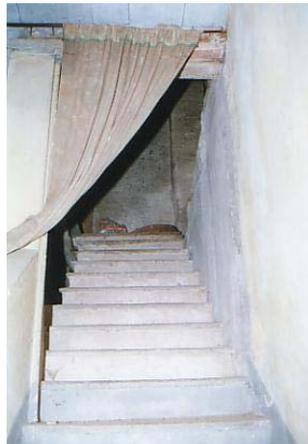
Vista della rampa con volta a botte rampante del sistema distributivo.
