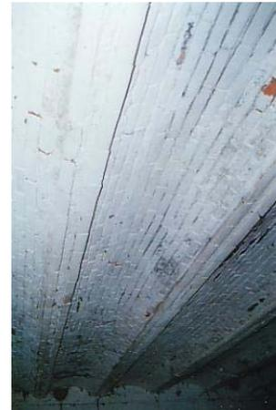
Particolare delle volte laterizie interne a copertura dell'edificio.
